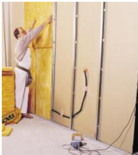
Установка теплоизоляции враспор
